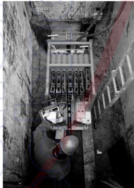
FIGURA 7 - pipe bursting statico: macchina tira aste con snakes (per gentile concessione di Volta Macchine Srl e TRACTO-TECHNIK GmbH & Co. KG.)
