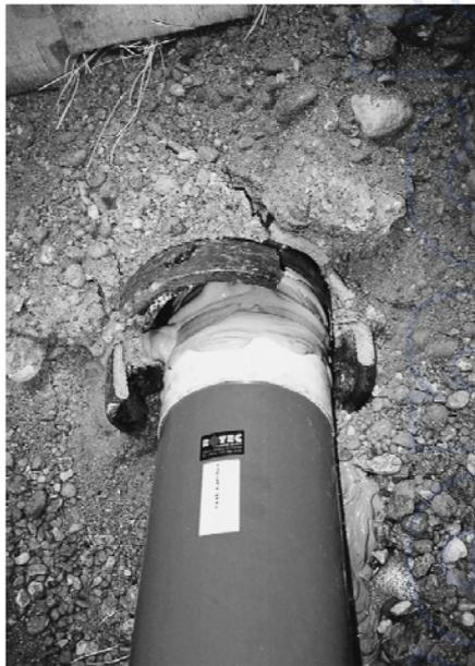
FIGURA 6 - pipe bursting statico: entrata dell'espansore nel tubo ospite (per gentile concessione di Volta Macchine Srl e TRACTO-TECHNIK GmbH & Co. KG.)
