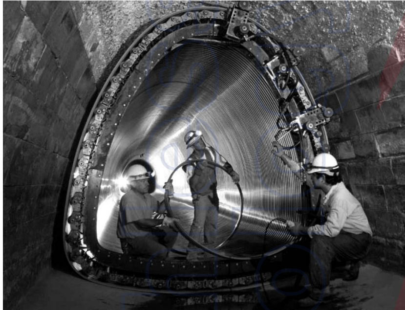
Figura 5 - winding machine dinamica nel risanamento di un collettore fognario (per gentile concessione di SEKISUI SPR Europe GmbH).
