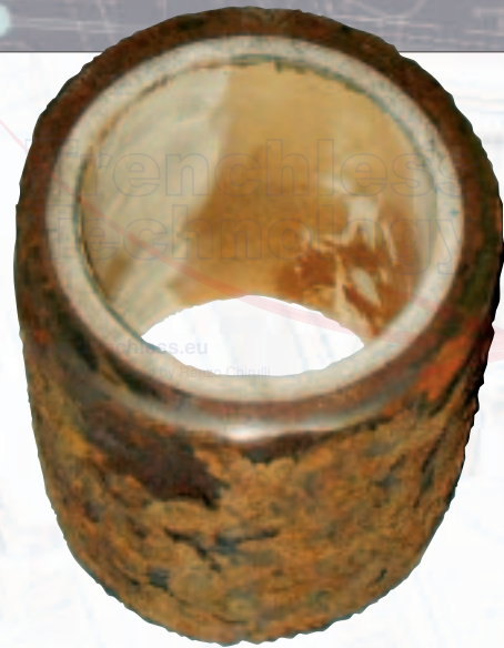
UN TRONCHETTO DI TUBAZIONE METALLICA DN80, PRELEVATO DA UN ACQUEDOTTO INGLESE IN VIA DI DISMISSIONE, NEL QUALE OLTRE 50 ANNI FA ERA STATO APPLICATO UN RIVESTIMENTO INTERNO IN MALTA CEMENTIZIA CON SPESSORE PARI A 6 MM
