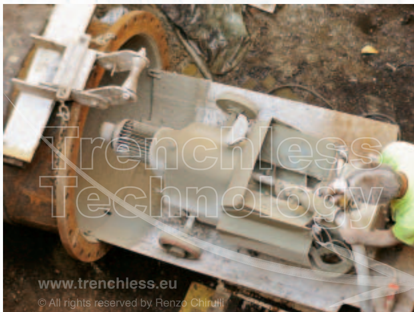
LINING MACHINE, PROGETTATA, COSTRUITA ED UTILIZZATA NEL LAVORO DI MILANO
