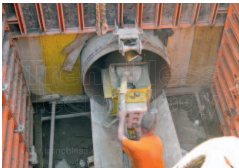
LINING MACHINE, PROGETTATA, COSTRUITA ED UTILIZZATA NEL LAVORO DI MILANO
