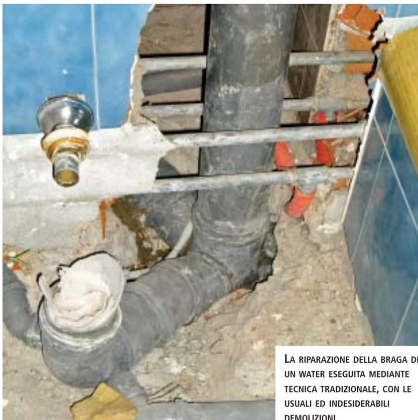
LA RIPARAZIONE DELLA BRAGA DI UN WATER ESEGUITA MEDIANTE TECNICA TRADIZIONALE, CON LE USUALI ED INDESIDERABILI DEMOLIZIONI
