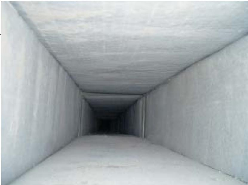
UN CONDOTTO DELL'ARIA CONDIZIONATA DOPO IL TRATTAMENTO CON COATING ANTIBATTERICO (PER GENTILE CONCESSIONE DELLA IN.TEC. SRL)
