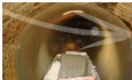
FIGURA 6 - UNA RIPRESA DALL'INTERNO DI UNA TUBAZIONE PRATICABILE DURANTE L'APPLICAZIONE DEL RIVESTIMENTO IN MALTA CEMENTIZIA
