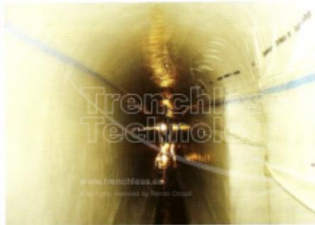
FIGURA 7: IL COLLETTORE AL TERMINE DELL'INTERVENTO DI RIABILITAZIONE. IL NUOVO TUBO ADERISCE PERFETTAMENTE ALLE PARETI DEL COLLETTORE PREESISTENTE.
