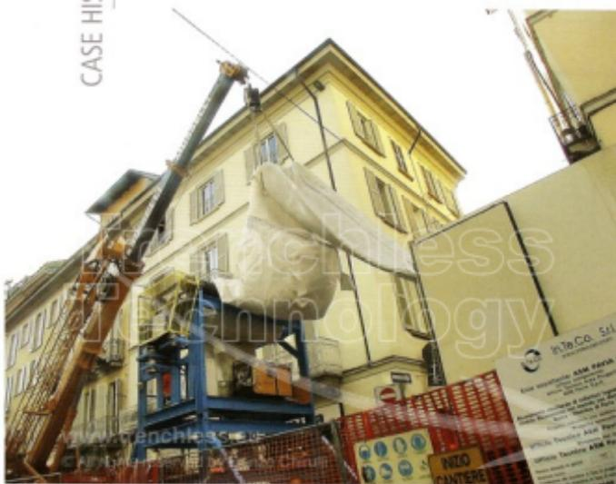
FIGURA 4: UNA FASE DELL'INSERIMENTO DEL LINER NEL COLLETTORE
