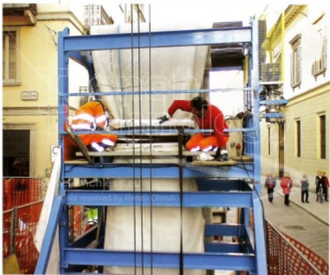
FIGURA 5: PARTICOLARE DELL'ANELLO DI INVERSIONE PER L'INSERIMENTO DEL LINER NEL COLLETTORE MEDIANTE COLONNA D'ACQUA
