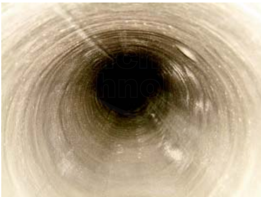
TUBAZIONE DI ACQUEDOTTO RIABILITATA MEDIANTE CEMENTAZIONE (CML). PER GENTILE CONCESSIONE DELLA RISANAMENTO CONDOTTE SRL (MILANO)
