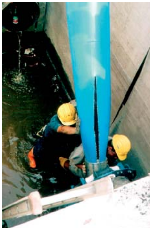
RIABILITAZIONE DI UN'ADDUTTRICE IDRICA MEDIANTE INSERIMENTO DI LINER IN MATERIALE COMPOSITO (PLASTICO-FIBRA ARAMIDICA). PER GENTILE CONCESSIONE DELLA C.E.P.A. SRL, INSTALLATORE AUTORIZZATO DEL PRIMUS LINE PER S3 SONCINI SPA (POVIGLIO, RE).
