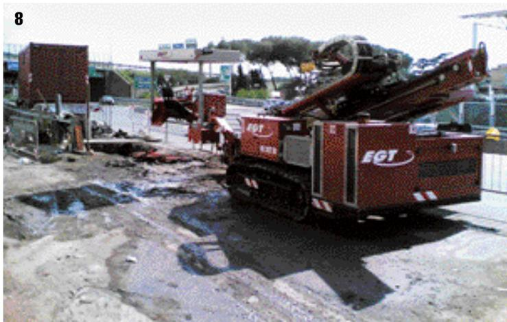
**8.** Fasi dell'installazione di una linea in media tensione da 20 kV per ACEA Spa - Roma - la perforatrice direzionale da superficie impiegata per le installazioni
