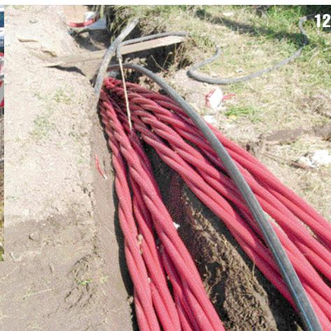
**12.** Fasi dell'installazione di una linea in media tensione da 20 kV per ACEA Spa - Roma - il fascio cavi durante la fase di tiro
