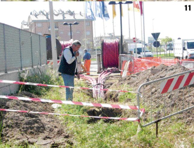
**11.** Fasi dell'installazione di una linea in media tensione da 20 kV per ACEA Spa - Roma - il fascio cavi durante la fase di tiro
