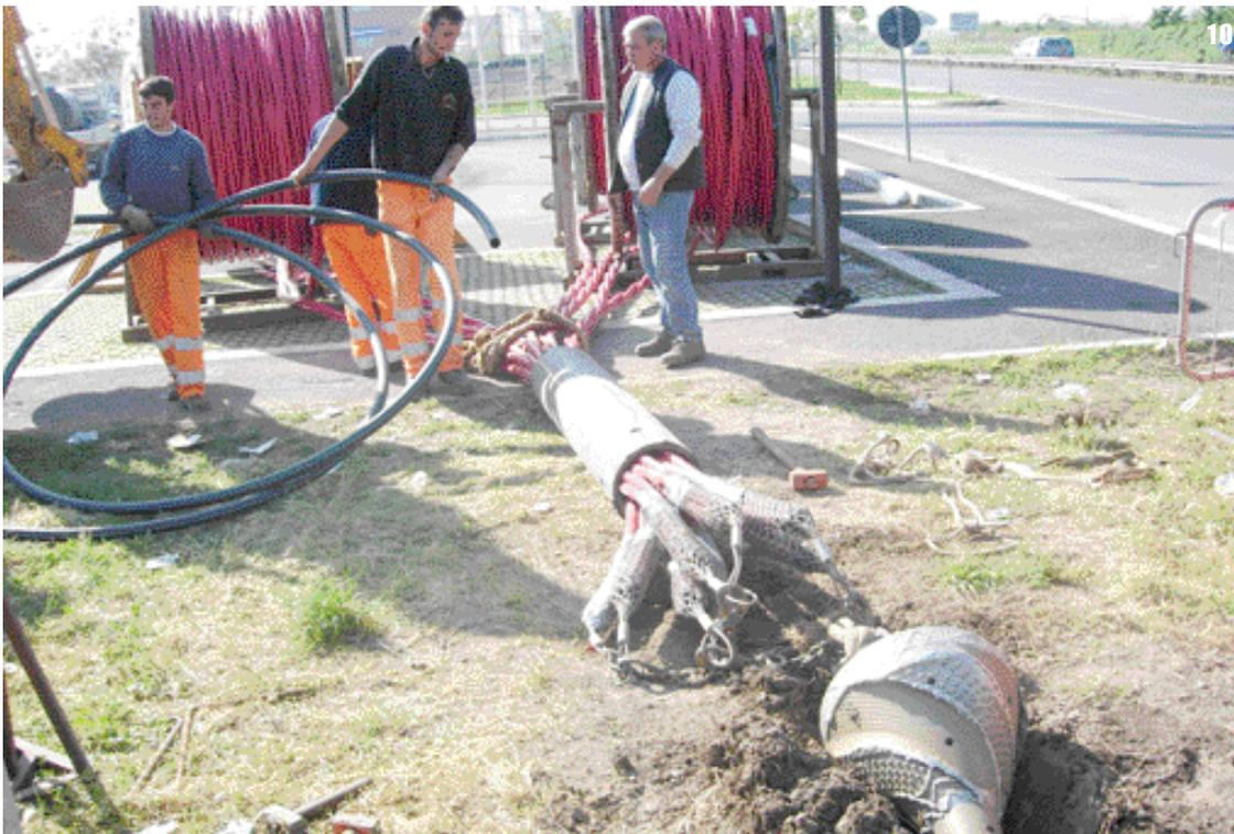
**10.** Fasi dell'installazione di una linea in media tensione da 20 kV per ACEA Spa - Roma - particolare dell'alesatore e delle calze di ancoraggio del fascio costituito da 8 terne di cavi
