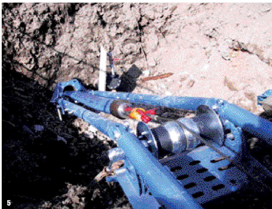
5. Applicazione del PRIMUS-LINE® nella riabilitazione di una condotta in acciaio: la testata del liner all'arrivo nel pozzo di partenza (per gentile concessione di S3 Soncini Spa)
