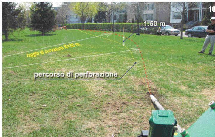
strumentista, quando questi si trova esattamente sulla verticale del trasmettitore, determina anche la posizione planimetrica del trasmettitore e quindi della punta di perforazione. In questo modo sono note le tre coordinate spaziali x, y, z (con origine ad esempio rispetto alla perforatrice), nonché l'inclinazione e l'orientamento della punta.
