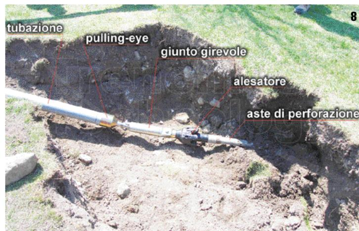
8. Inizio della fase di alesatura e tiro con indicazione dei componenti del treno di alesatura e tiro
