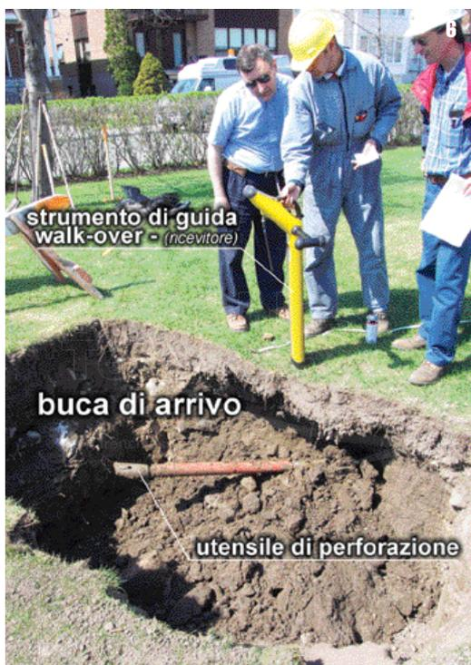
gie No-Dig, anche nel directional drilling il principale elemento caratterizzante è proprio la possibilità di effettuare queste applicazioni limitando drasticamente o eliminando del tutto gli scavi a cielo aperto.
