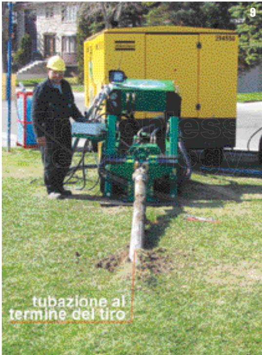
9. Arrivo della tubazione nella sezione di partenza (termine dell'installazione)
