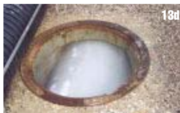
13a, 13b, 13c, 13e. Caso 2 - Sequenza del passaggio del liner in corrispondenza di un pozzetto d'ispezione, durante la fase di inserimento per inversione ad acqua.
