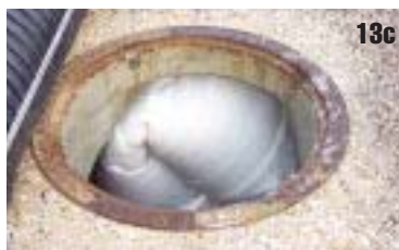
13a, 13b, 13c, 13e. Caso 2 - Sequenza del passaggio del liner in corrispondenza di un pozzetto d'ispezione, durante la fase di inserimento per inversione ad acqua.
