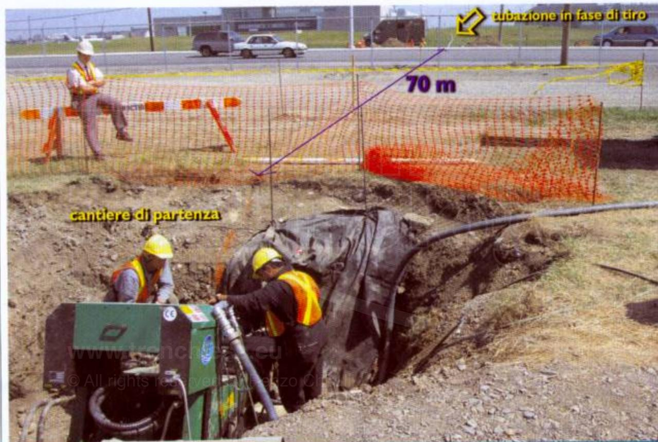
FIGURA 4: INSTALLAZIONE DI CAVIDOTTI PER CAVI ELETTRICI DI MEDIA TENSIONE IN CORRISPONDENZA DI UNA STRADA AD ELEVATO TRAFFICO – AEROPORTO DI DORVAL – MONTREAL, QC – CANADA
