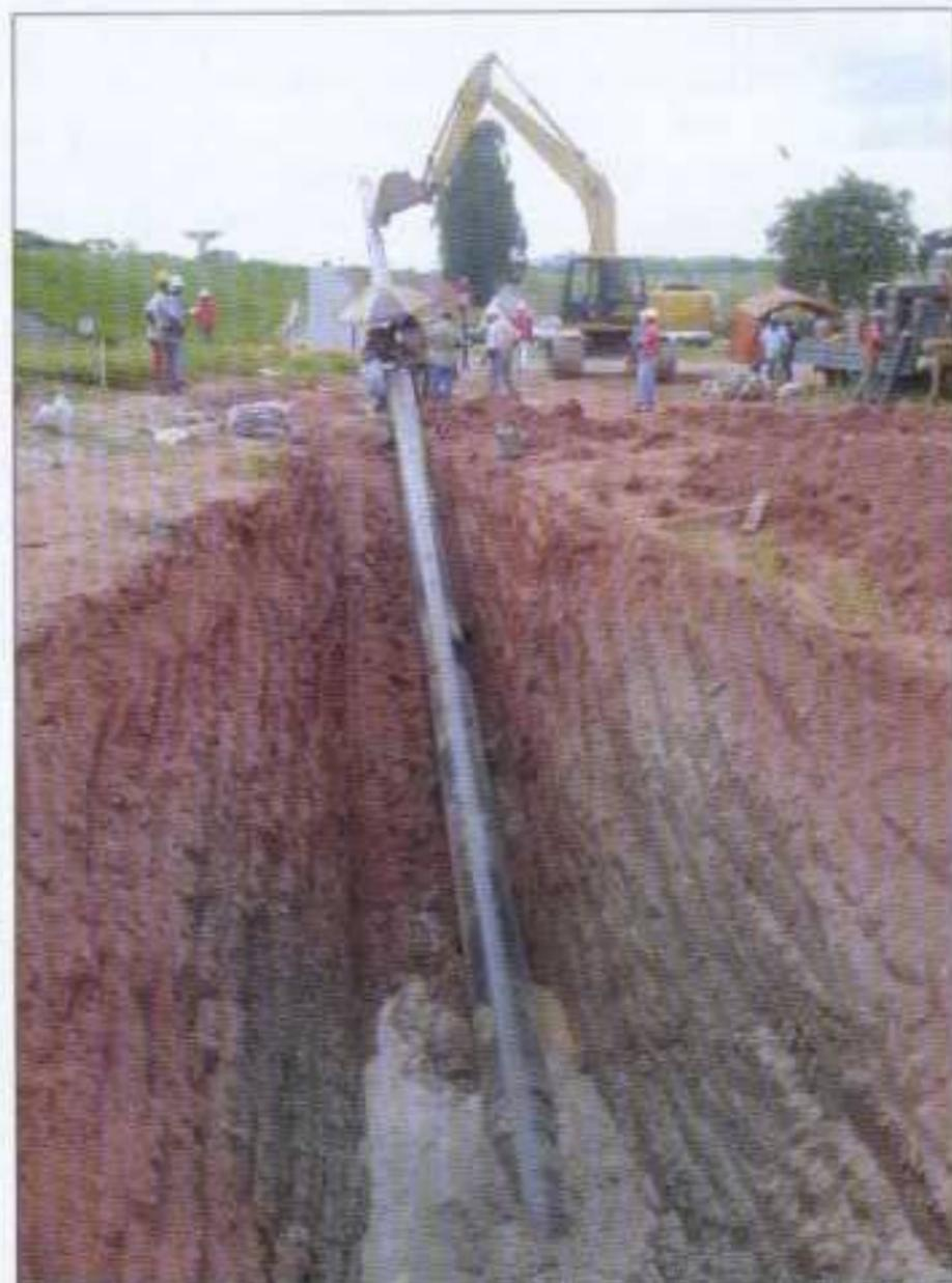
Fase di tiro di una condotta in acciaio da 400 mm in un attraversamento fluviale realizzato con macchine per Dry Directional Drilling della SE - Novembre 2000. Fonte SE Srl.
