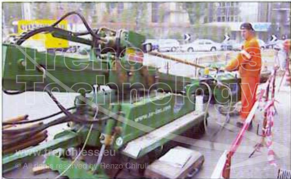
Lavori Metroweb a Milano con macchine per Dry Directional Drilling della SE - Ottobre 2001. Fonte IT Consulting
