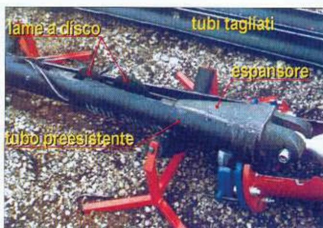
Figura 10 - Pipe Splitting. Un esempio d'impiego su una tubazione metallica.
