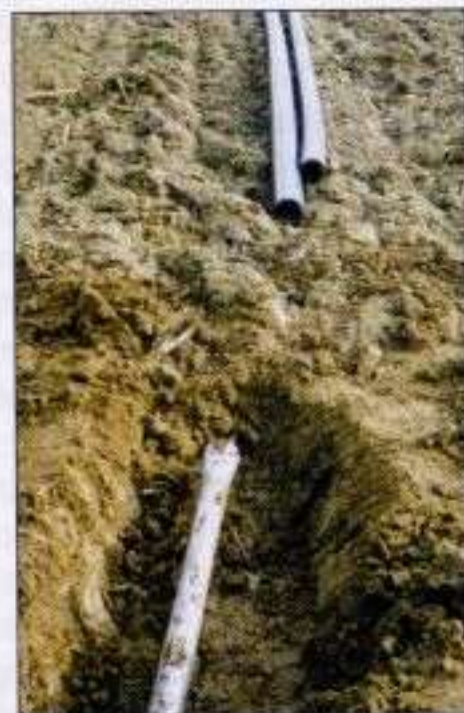
fig. 6 - Repubblica Ceca, febbraio 1999 - posa di un acquedotto in PEAD DN300 per una lunghezza di tiro pari a 160 m: a) buca di arrivo, in basso si nota la punta di perforazione da DDD in emersione; b) un momento del tiro della condotta nel foro - (per gentile concessione della SE S.r.l. - Italia).
