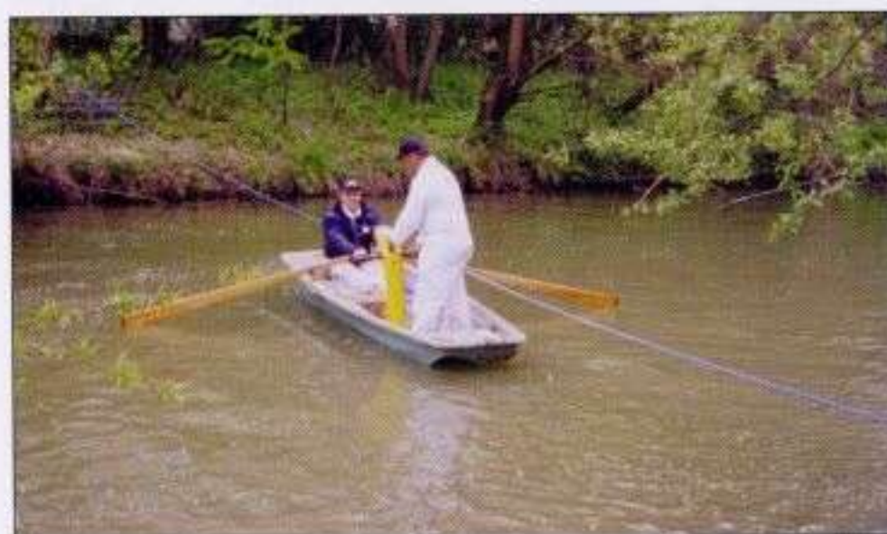
fig. 5 - Austria, aprile 1999- Attraversamento fluviale per la posa di un gasdotto (lunghezza di tiro 250 m, diametro della condotta DN 160 in PEAD): a) perforatrice da DDD a terra, stazione di partenza; b) controllo direzionale in sub alveo mediante sistema radio di tipo walk over - (per gentile concessione della SE S.r.l. - Italia)
