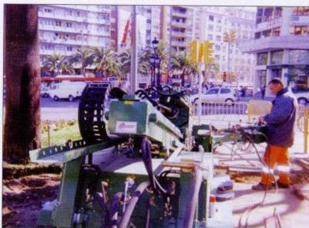
fig. 3 - Plaza Francesc Macià - Barcelona (España)- giugno 1999 - Realizzazione di un anello per reti di telecomunicazione attorno alla piazza, mediante DDD - (per gentile concessione della SE S.r.l. - Italia)
