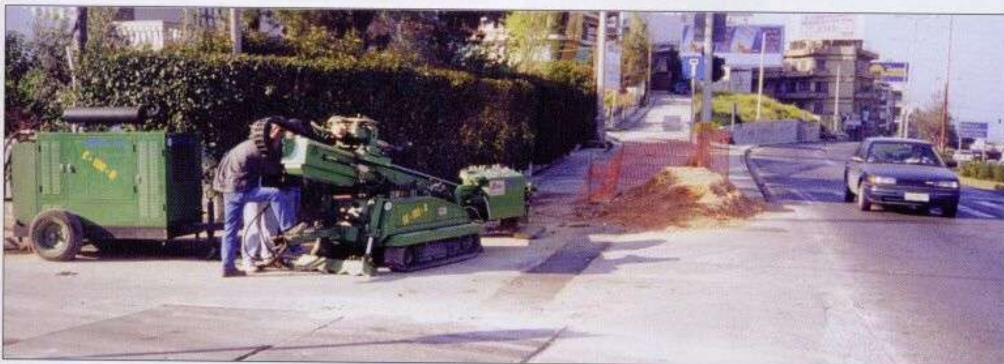
fig. 4 - Atene (Grecia) - Febbraio 1999 - Attraversamento stradale in zona urbana mediante DDD - (per gentile concessione della SE S.r.l. - Italia)
