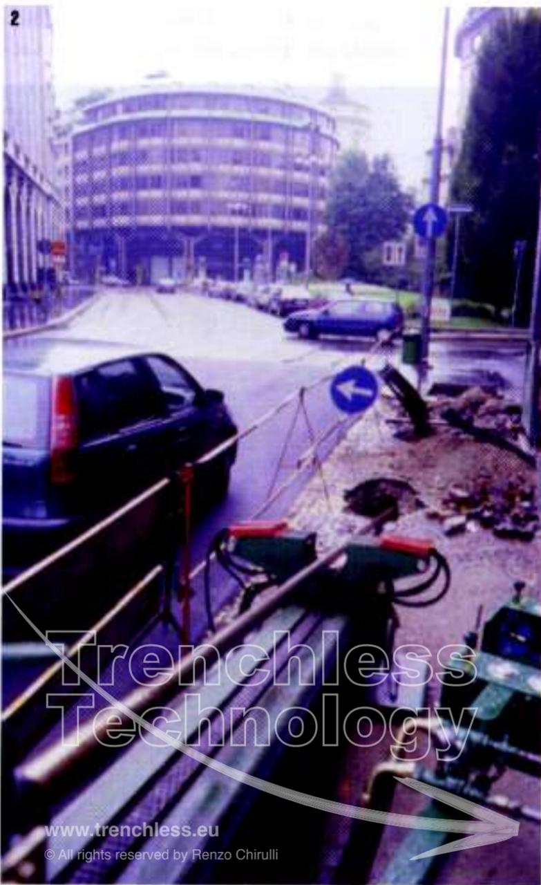
**3. Un cantiere per l'attraversamento, mediante directional drilling, di una strada ad intenso traffico veicolare - la linea rappresenta l'asse seguito durante la perforazione.**
