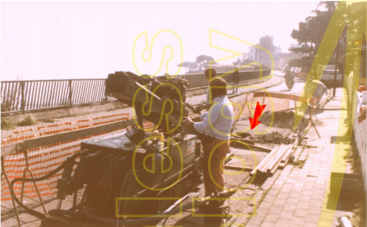
Fig. 17 – Cantiere da DDD, per l'installazione, in zona urbana, di cavi per telecomunicazioni. La freccia indica la buca di partenza.
