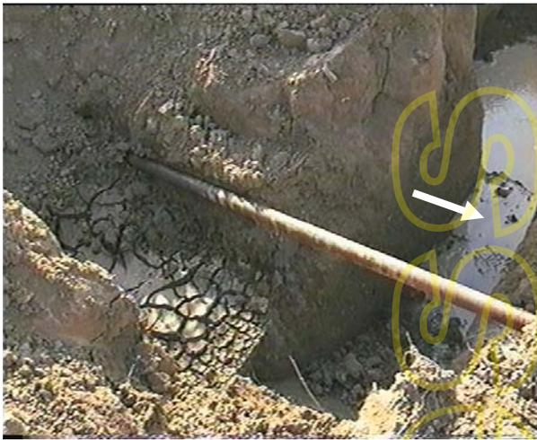
Fig. 14 – Wet boring buca di partenza. La freccia indica la buca di recupero del fango.
