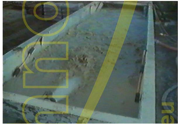
Fig. 12 – Vasca di miscelazione del fango bentonitico. (fonte: SNAM S.p.A.)
