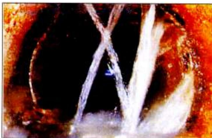
La ripresa effettuata con telecamera robotizzata, mostra le infiltrazioni che interessano una condotta fognante soggetta a dissesto.
