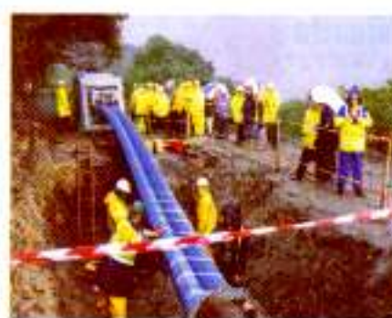
FIG. 12 - impiego del U-lining per una tubazione di grande diametro
