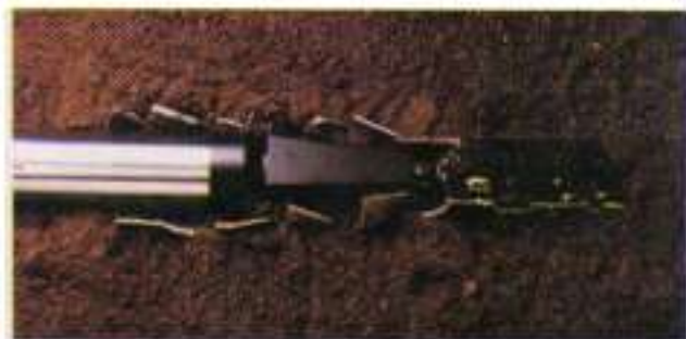
FIG. 7 - Pipe bursting
