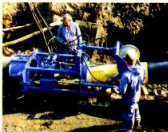
FIG. 11 - inserimento di una nuova condotta in polietilene in una esistente in acciaio (close fit)
