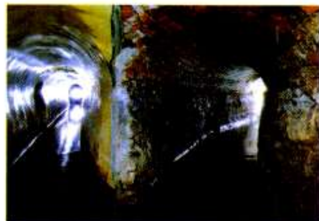
Fig. 10 - Applicazione del CIPP ad un collettore fognario in muratura di grande sezione
