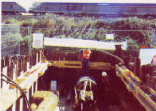
▲ FIG. 21 - Attraversamento ferroviario con pipe ramming
