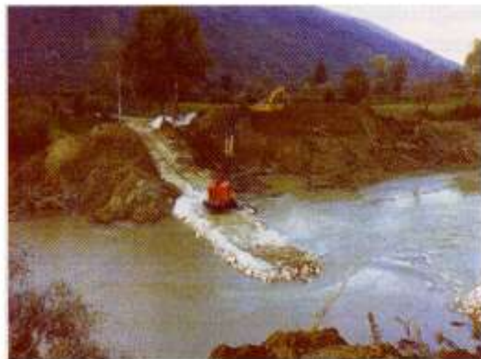
FIG. 18 - Il grande impatto ambientale causato da un attraversamento fluviale operato con drag-line
