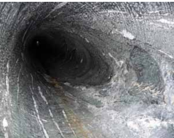
Foro in quarzite DN800 realizzato con SBU-A 32
